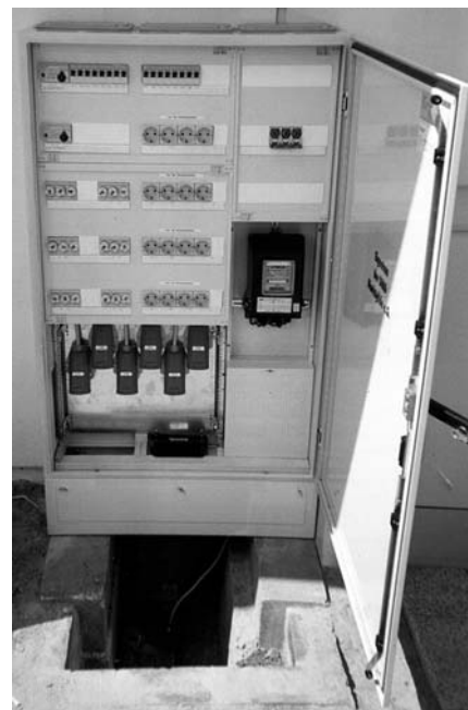
Der DMG-Stromverteiler in der Bauphase auf dem Winterberger Wochenmarkt.
